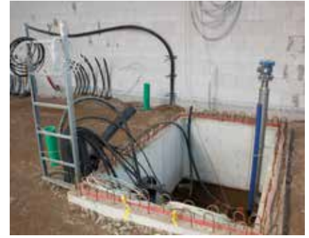
KRASO® Pumpensumpf - Beton - Sonder Innenmaße ca. 250 x 150 x 120 cm, 3 x KRASO® Kabeldurchführung KDS 150 einseitig Paket 1 x 3, KRASO® Futterrohr Typ FE ID 200 einseitig mit eingeschweißter Muffe, aus WU-Beton, mit 20 cm starken, stahlfaserbewehrten Wand- und Bodenplatten ( 20 kg/ per cbm ). Anschlussbewehrung ca. 8/15 doppelreihig, umlaufendes, druckwasserdichtes, MPA-geprüftes Arbeitsfugenband KRASOflex® Duo-Fix 150 „plus“, 4 Transportanker Rd30, Gewicht/Stück: ca. 7,8 t
