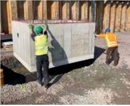
KRASO® Pumpensumpf - Beton - Sonder Innenmaße ca. 200 x 270 x 150 cm, Außenmaße ca. 250 x 320 x 175 cm, 2 KRASO® Futterrohre Typ FE ID 200, aus WU-Beton, mit 25 cm starken, stahlfaserbewehrten Wand- und Bodenplatten ( 20 kg/ per cbm ). Anschlussbewehrung ca. 8/15 doppelreihig, umlaufendes, druckwasserdichtes, MPA-geprüftes Arbeitsfugenband KRASOflex® Duo-Fix 150 „plus“, 4 Transportanker Rd30, Gewicht/Stück: ca. 15,30 t, mit Zusatzbewehrung gem. Angaben des Tragwerkplaners
